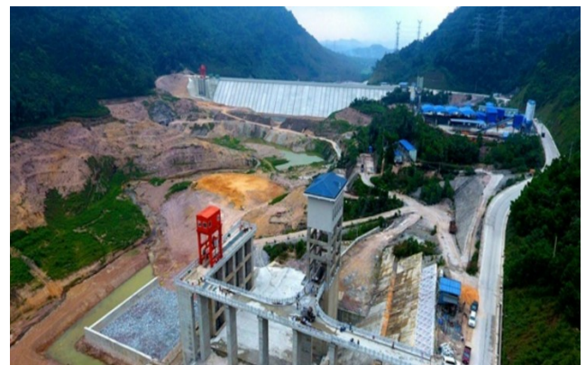
图 21: 琼中抽水蓄能电站下水库
