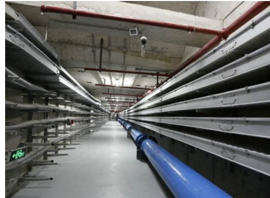
图 19：总长度 6.4KM 的上海世博源地下综合管廊
